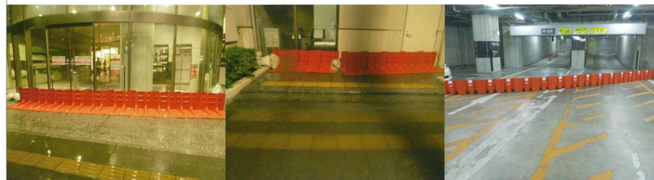
実際にボックスウォールを使用し、建物内に水が入るのを防いだ
